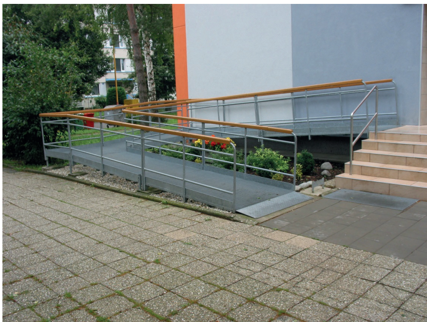
Rampa s povrchem z roštu
