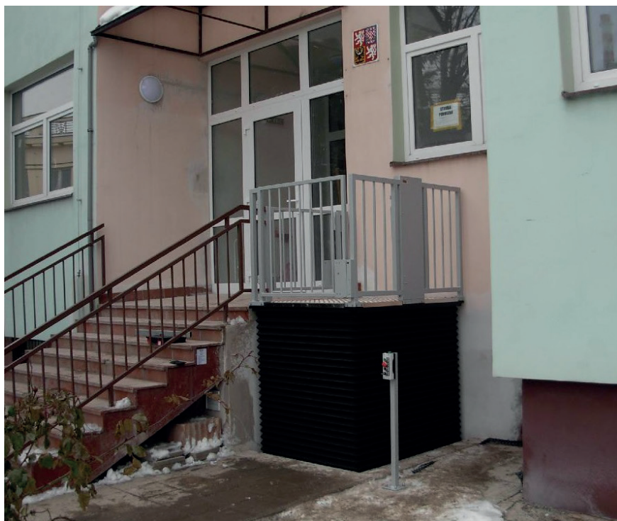
Svislá plošina v exteriéru
