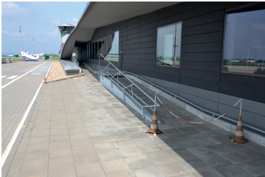
Rampa se zábradlím
