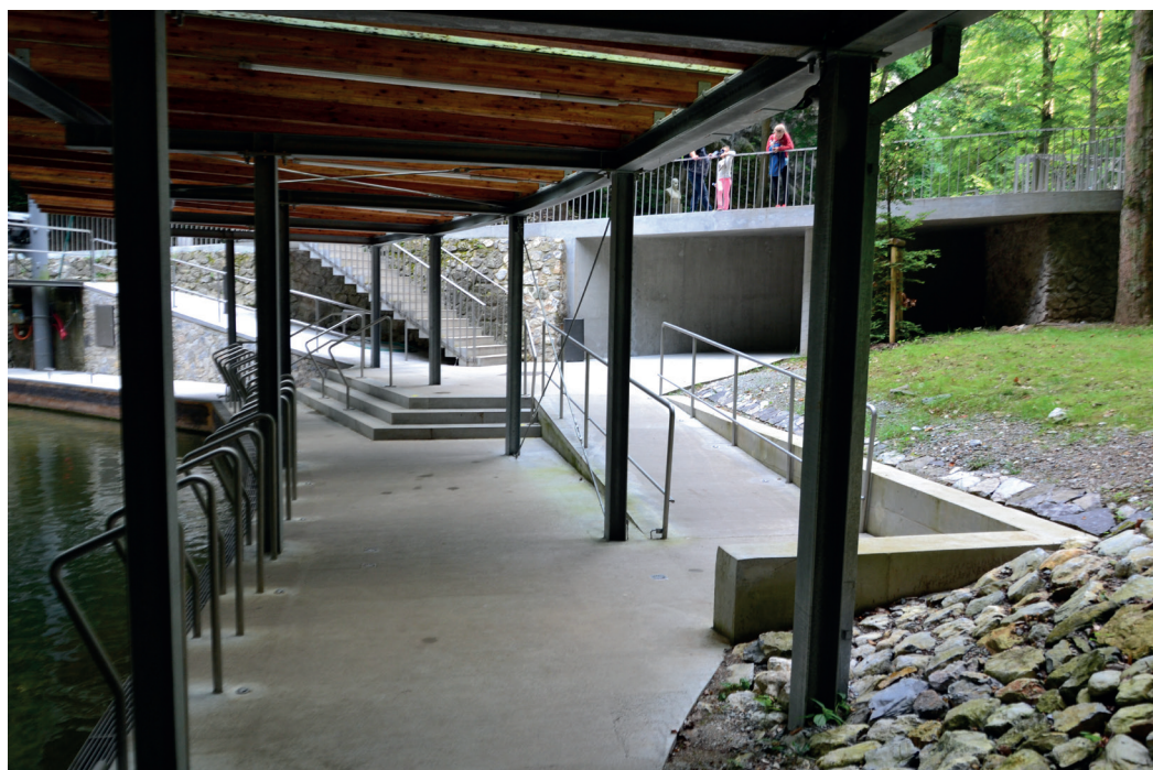
Rampa se zábradlím
