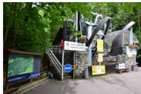
Stanoviště lanové dráhy
