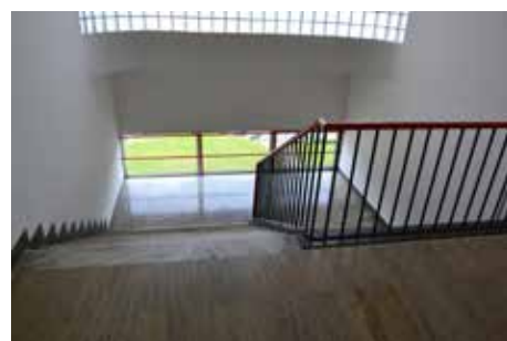
Administrativní budova - schodiště
