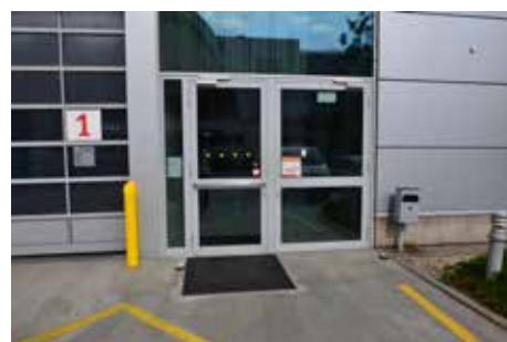
Vstup pavilonu F
