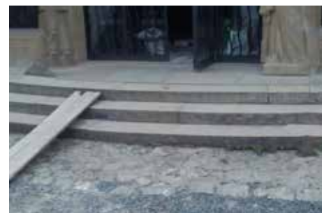
Schody před vstupem
